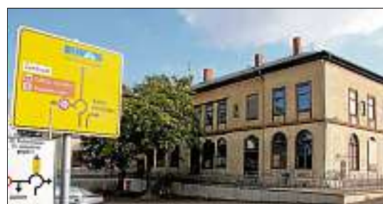
Bahnhof Waltershausen: Umgestaltung des Vorplatzes und Abriss des Bahnhofsbauwerks sollen 2017 erfolgen. Foto: Wieland Fischer
